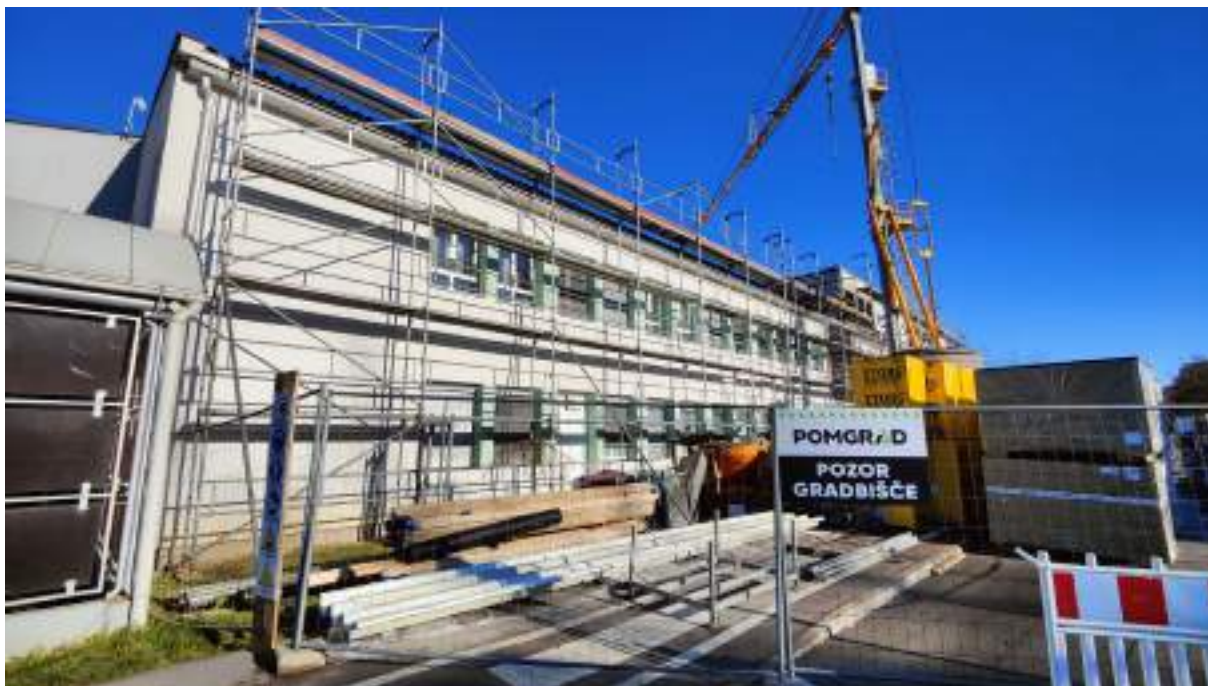
Slika 4: Ureditev zavarovanja gradbišča proti okolici
