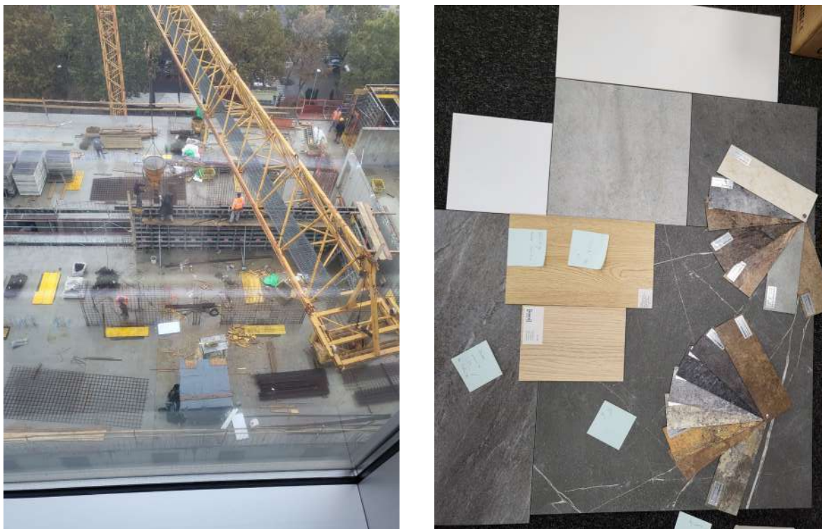
Slika 6: Sproti z izvedbo gradbenih del je že potekalo usklajevanje materialov
