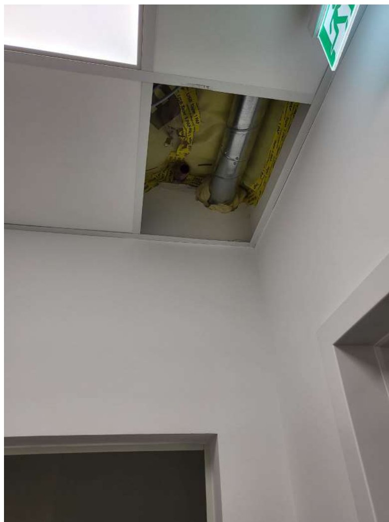
Slika 14: Končni videz toplotne izolacije plošče AB s spuščanim stropom (Lastni vir, 2024)
