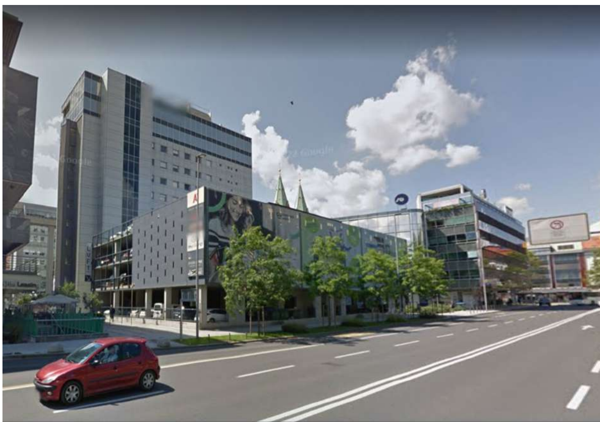
Slika 3: Stanje objekta tik pred predvideno nadzidavo hotela
