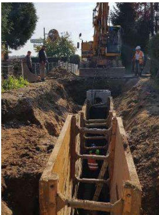
Slika 33: Vstavljanje jaška v razširjenem izkopu
