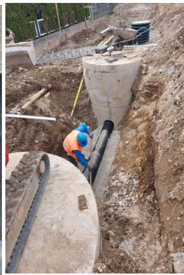
Slika 20: Povezava med ponikovalnicama
