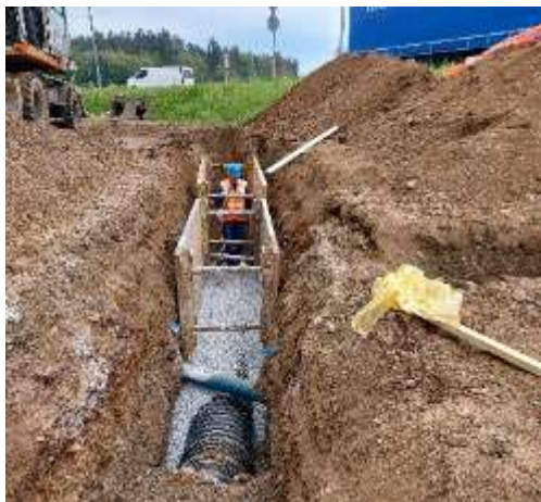
Slika 22: Križanje PP cev - vodovod
