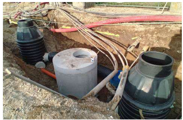
Slika 2: Oljni lovilec med vgradnjo
