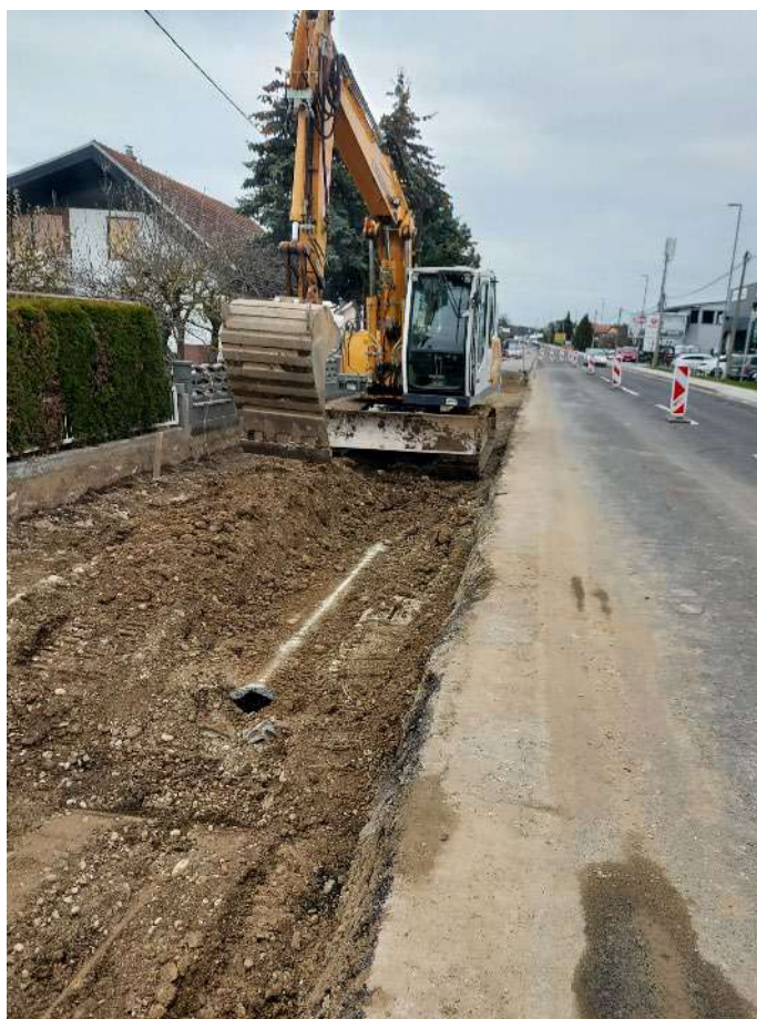
Slika 14: Rušitev betonskih cevi
