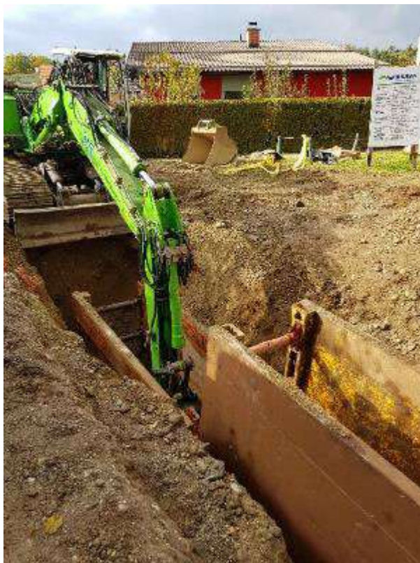
Slika 28: Izkop v opažu
