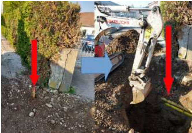
Slika 23: Ovirana postavitev peskolova
