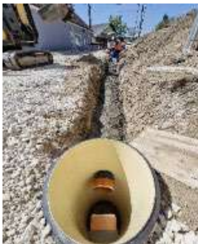
Slika 26: Povezava med požiralniki
