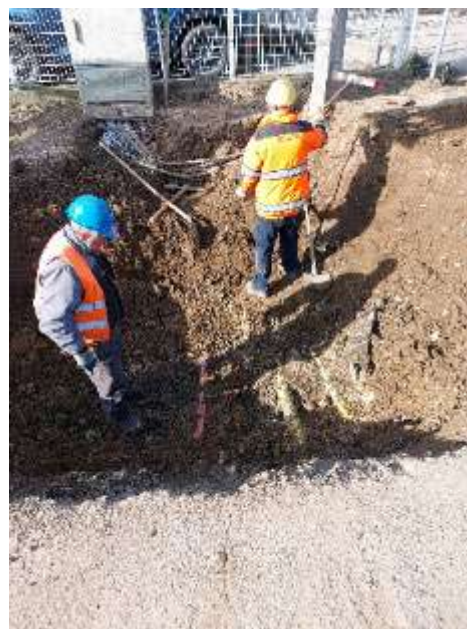
Slika 25: Ročno sondiranje med izkopom
