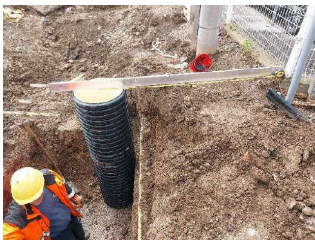
Slika 34: Lokacijska ter višinska prilagoditev jaška zaradi nepredvidenih vodov
