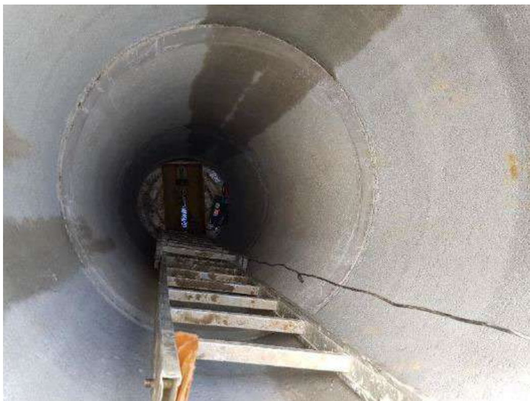
Slika 30: Kanalski laser v jašku
