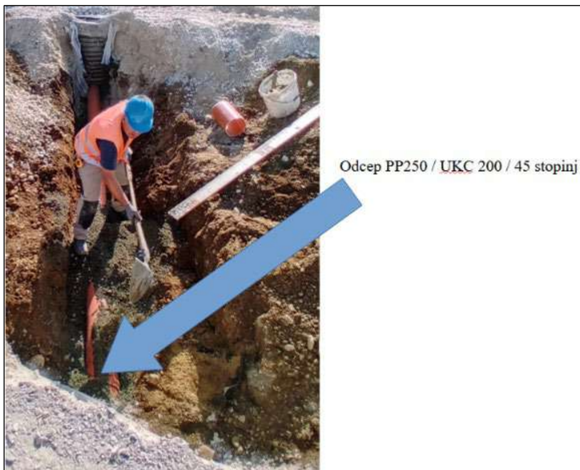
Slika 27: Povezava cev - požiralnik
