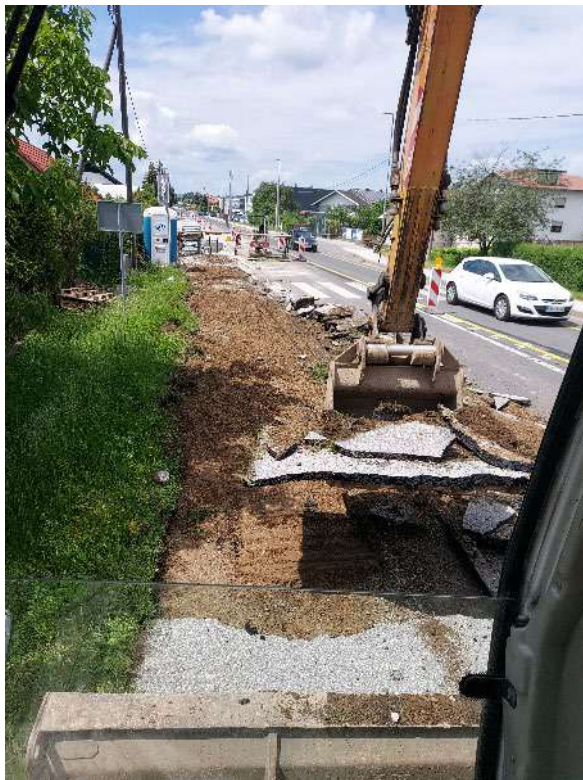
Slika 13: Rušitev asfaltne plasti
