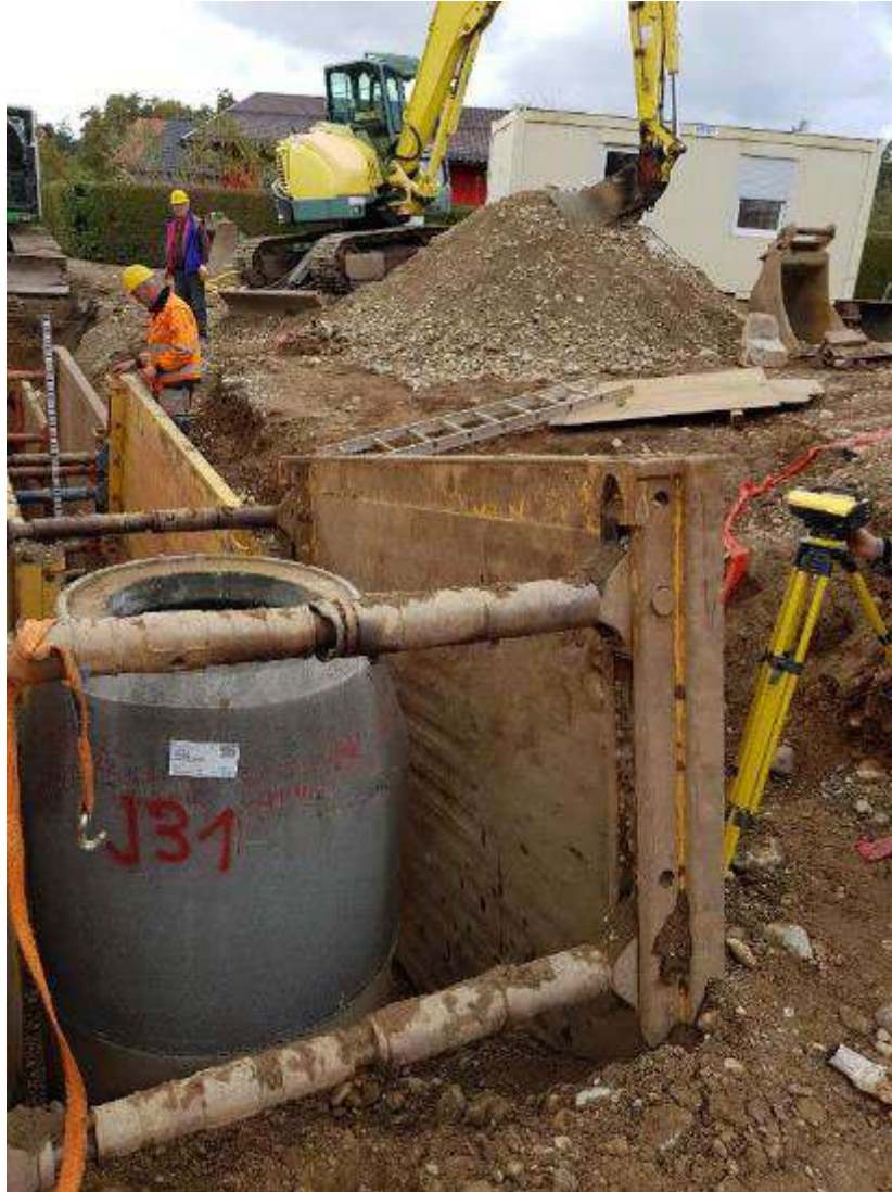
Slika 32: Vstavljanje jaška v opažu
