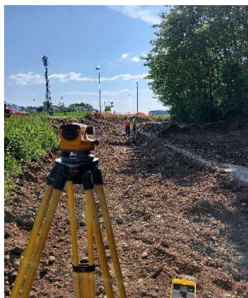
Slika 15: Kontrola višin z nivelirjem
