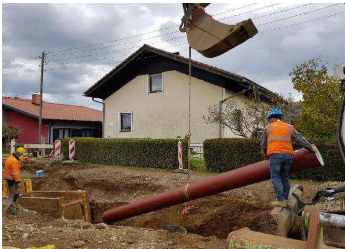
Slika 29: Vstavljanje cevi v opaž
