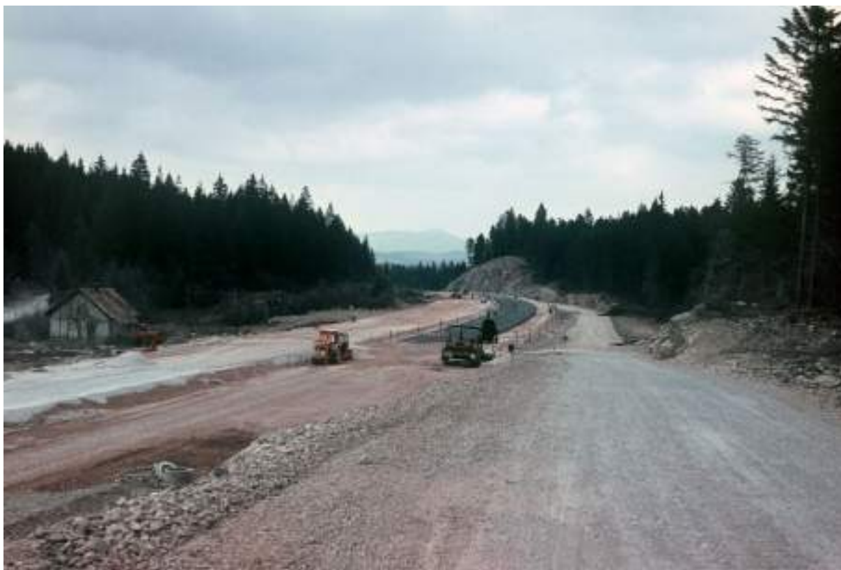
Slika 3: Gradnja prve slovenske avtoceste med Vrhniko in Postojno 1970
