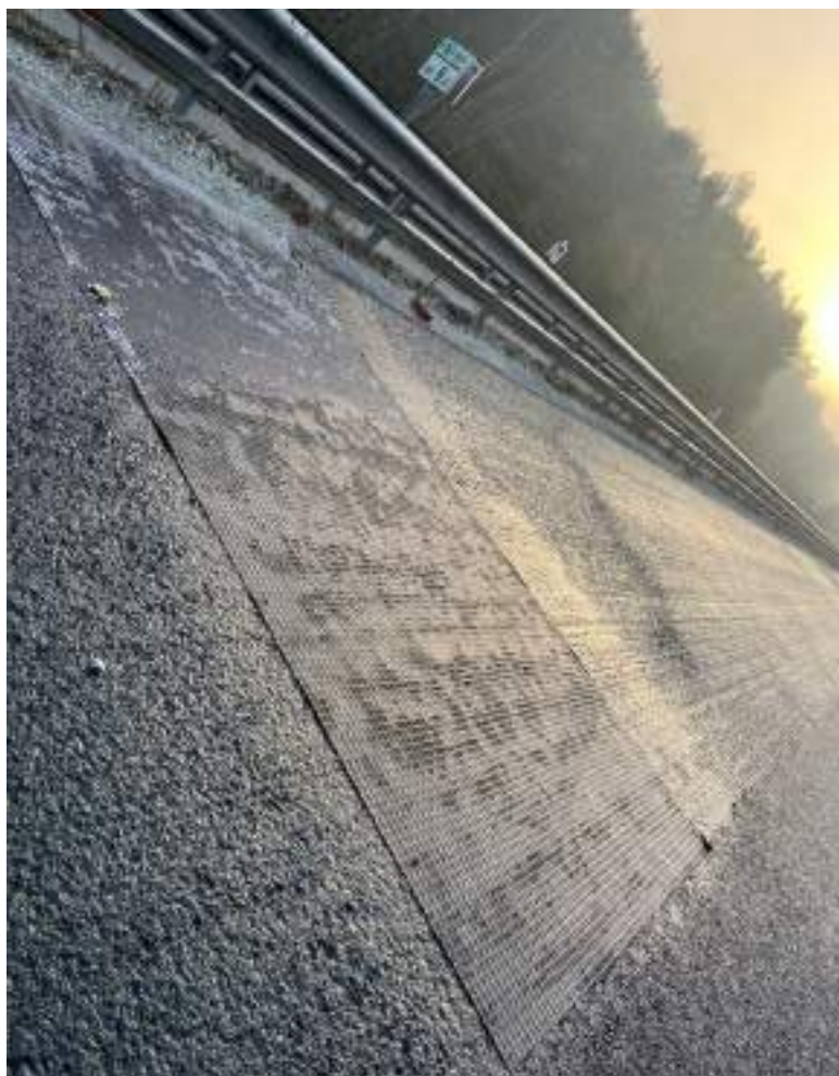
Slika 18: Pobrizg preko armirane mreže Vir: lasten
