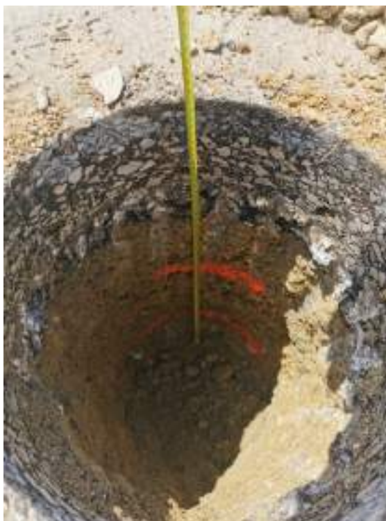
Slika 22: Razkop vzorca Vir: poročilo sondažni izkopi 1100/20-760-64, ZAG 2023
