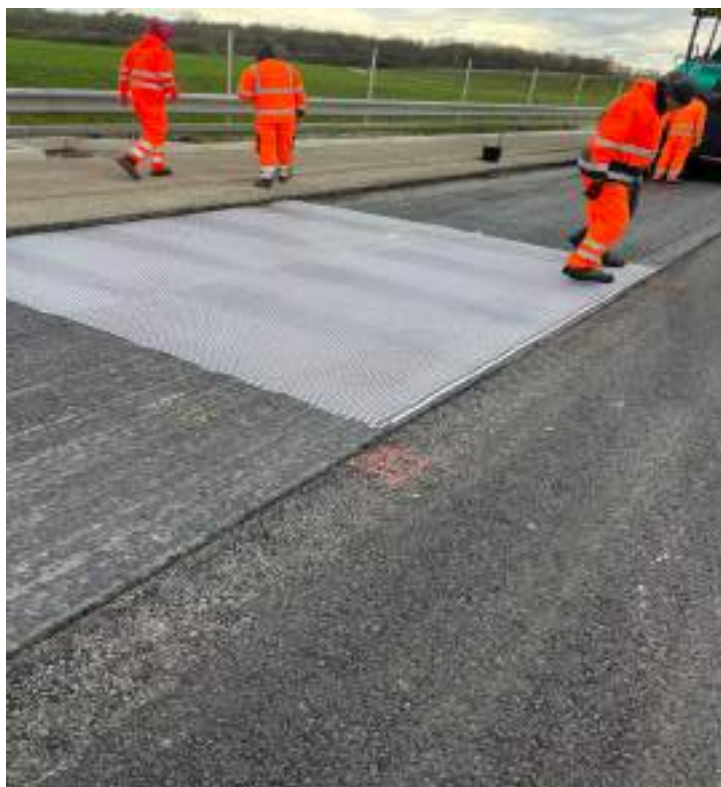
Slika 17: Vgrajevanje armirane mreže na prečni razpoki Vir: lasten
