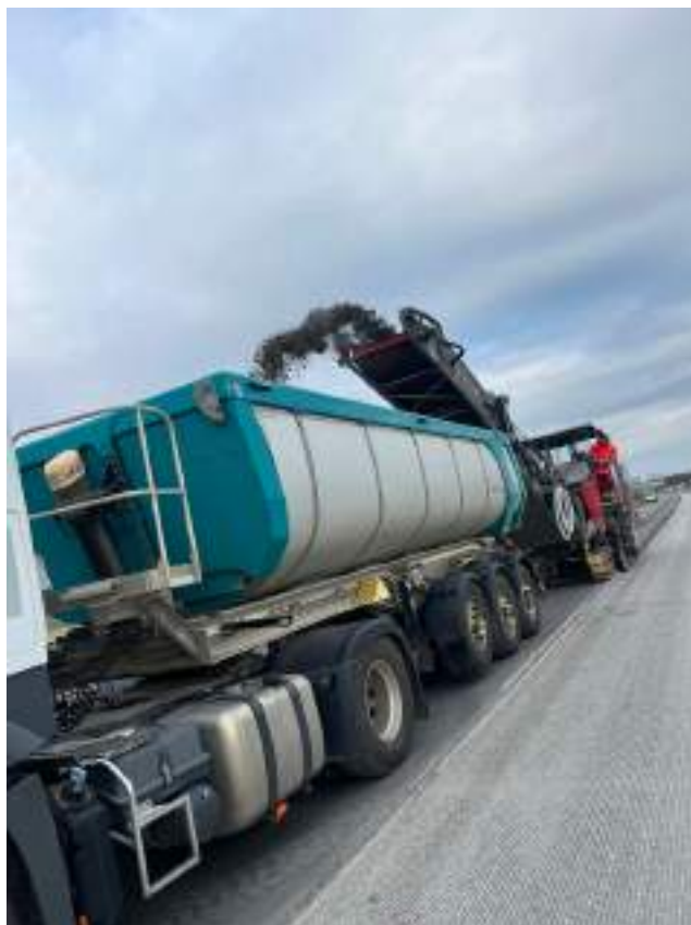
Slika 19: Rezkanje Vir: lasten
