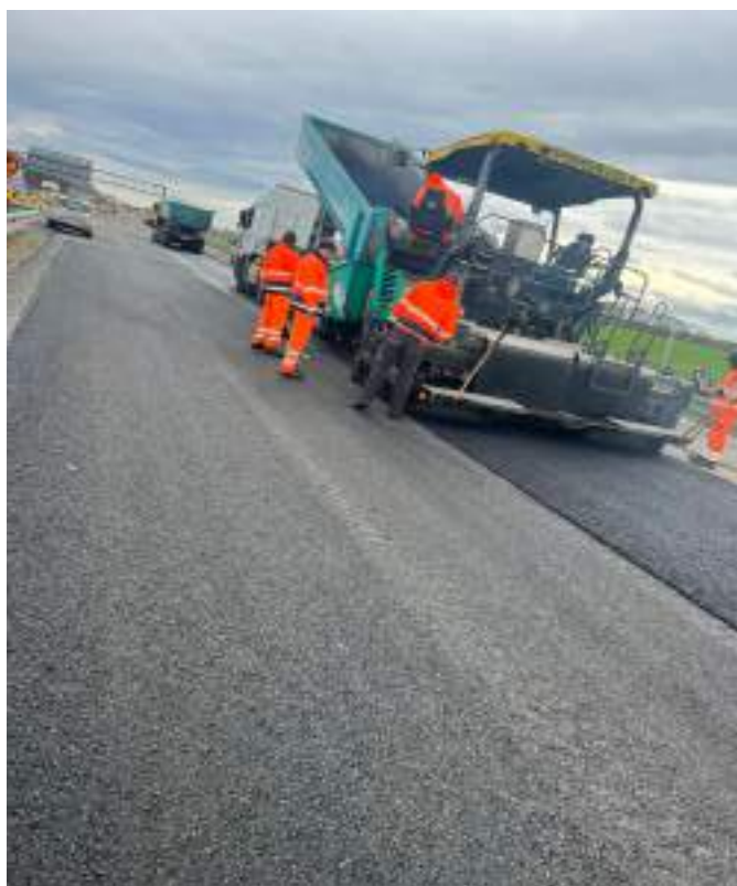
Slika 15: izvedba obrabne plasti SMA11 Vir: lasten
