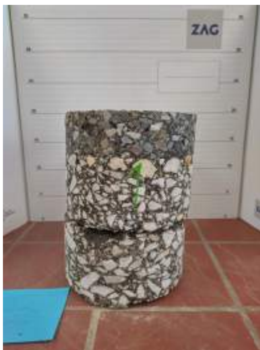
Slika 23: : asfaltno jedro vzorca 1, ki se je pri odvzemu razlepilo med plastema BASE in BIN. Vir: poročilo sondažni izkopi 1100/20-760-64, ZAG 2023
