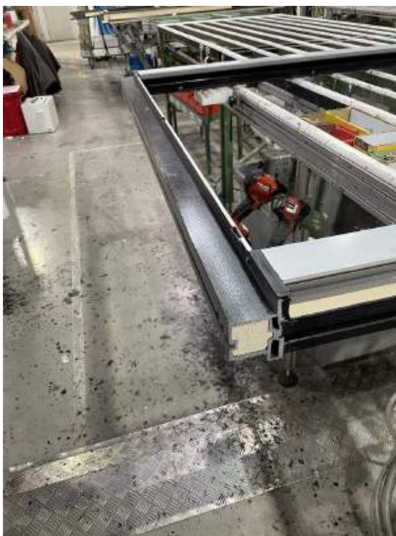
Slika 48: Montaža pragov na okvir vrat
