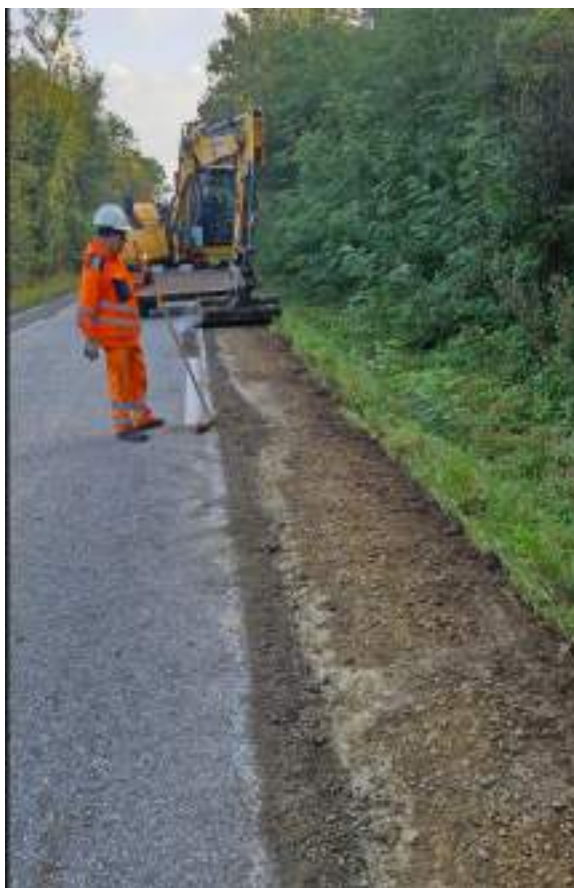
Slika 15: Pravilno porezana bankina – preprečitev zastajanja vode
