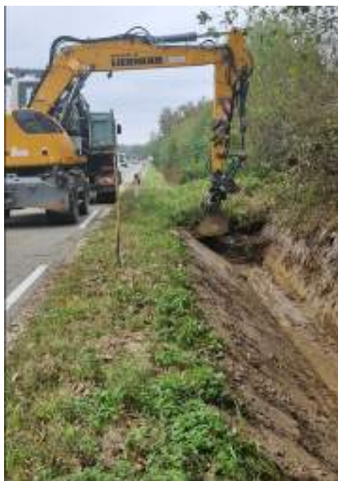
Slika 16: Pravilno očiščen jarek – preprečitev zastajanja vode
