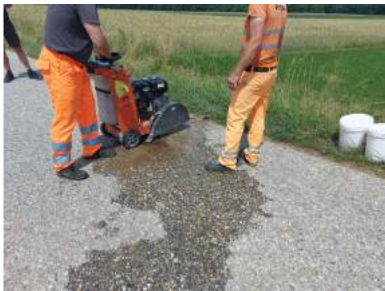
Slika 10: Rezanje obstoječega asfalta
