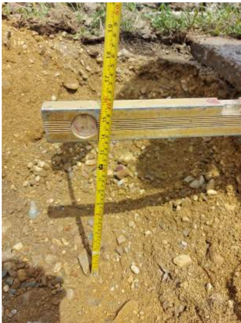
Slika 13: Meritev debeline plasti nevezane nosilne plasti
