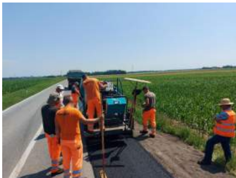
Slika 19: Pravilno krpanje z rezkanjem – sanacija poškodovanega vozišča
