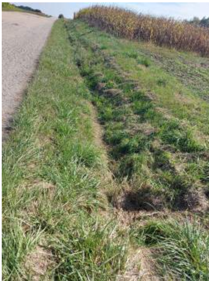
Slika 6: Stanje zaraščenega jarka in previsokih bankin na desni strani
