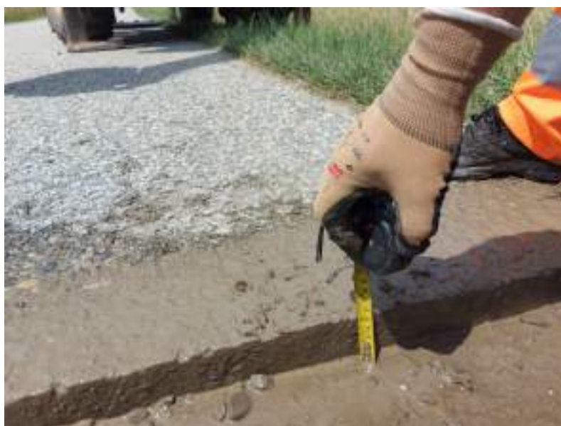
Slika 11: Izmera debeline plasti asfalta
