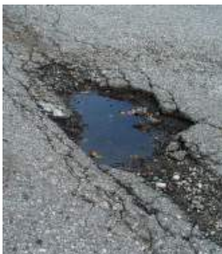
Slika 17: Razgraditev asfaltne zmesi – udarna jama
