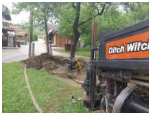
Slika 22: Primer namestitve vrtalnega stroja
