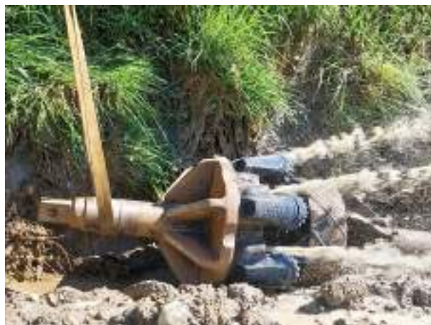
Slika 26: Prikaz vrtalne glave s pršenjem bentonitne suspenzije
