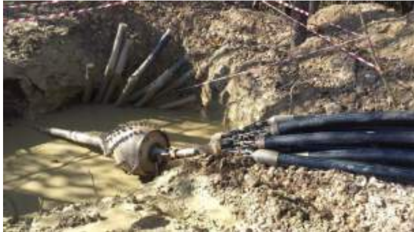
Slika 25: Prikaz povrtavanja vrtine z uvlekom cevi (3. faza)
