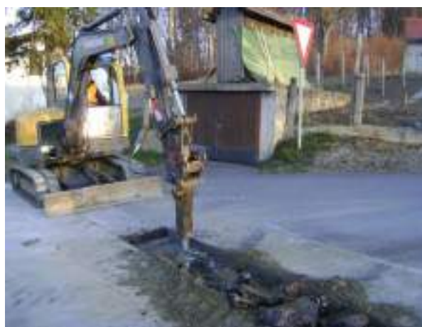
Slika 5: Rušenje asfalta
