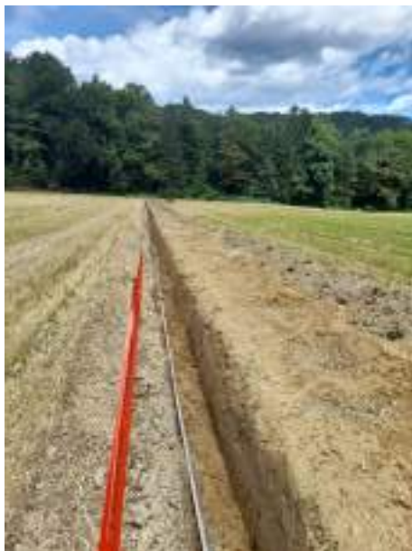
Slika 2: Strojni izkop jarka
