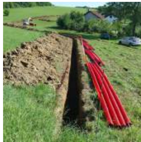
Slika 3: Kabelski jarek in priprava cevi
