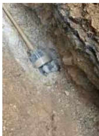
Slika 24: Prikaz povrtavanja vrtine (2. faza)
