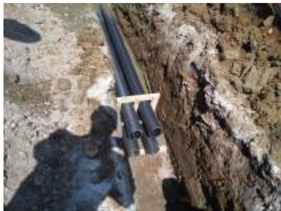
Slika 10: Izvedba EKK
