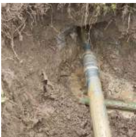
Slika 23: Izvedba pilotne vrtine (1. faza)
