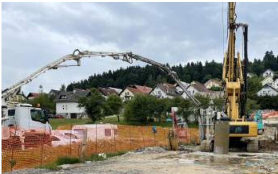
Slika 10: Betoniranje pilotov in izvlek jeklene opažne cevi za nakupovalni center CP Ravne
