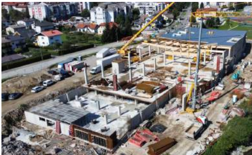
Slika 16: Fotografija konstrukcijskih elementov trgovskega centra Slovenj Gradec
