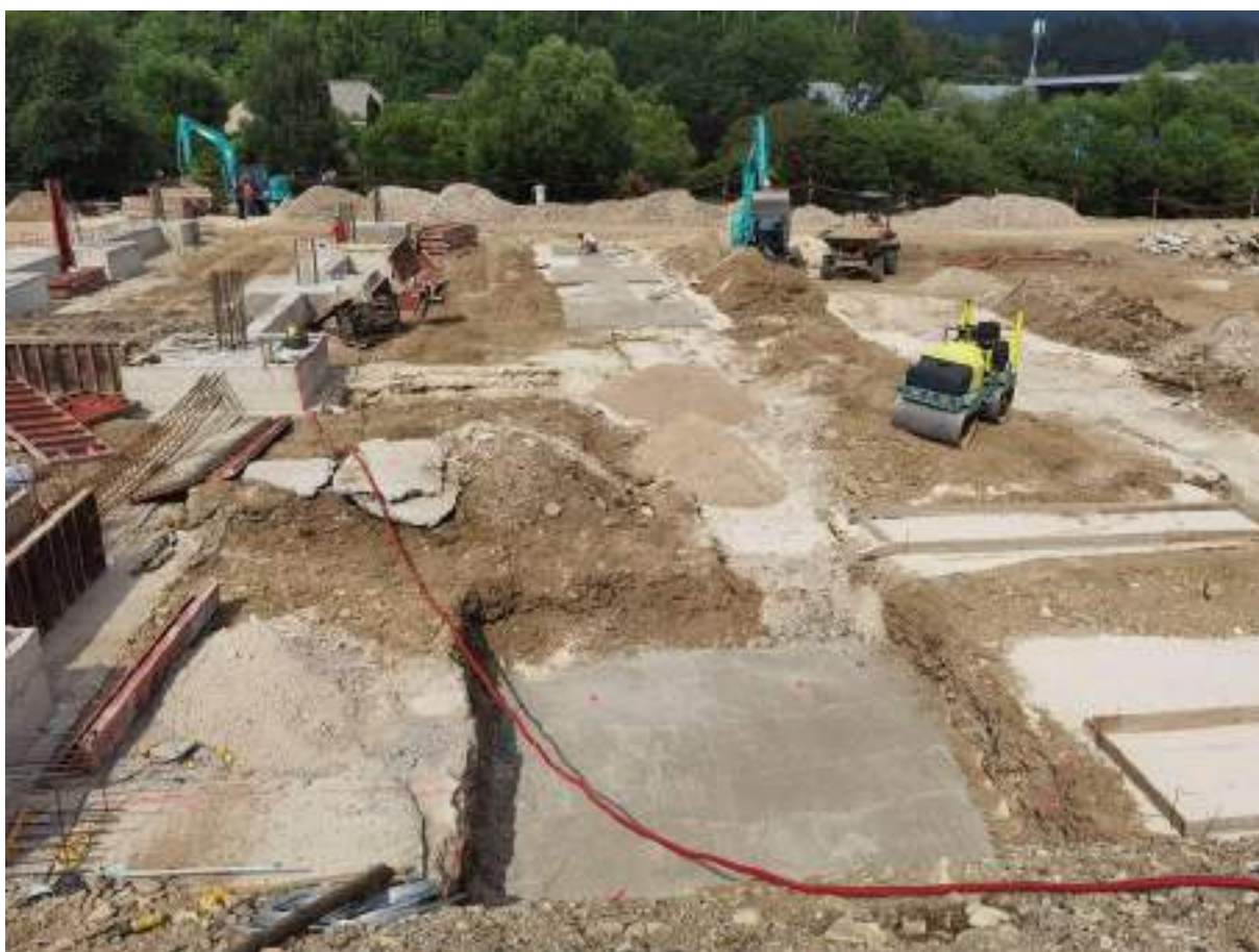
Slika 20: Sanacija temeljnih tal nakupovalnega centra Slovenj Gradec
