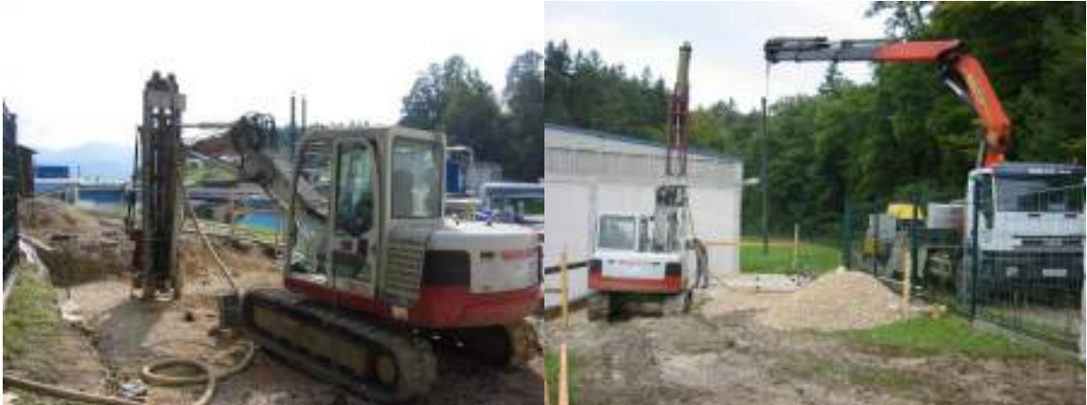
Slika 26: Zabijanje pilotov (vertikalno in pod naklonom)
