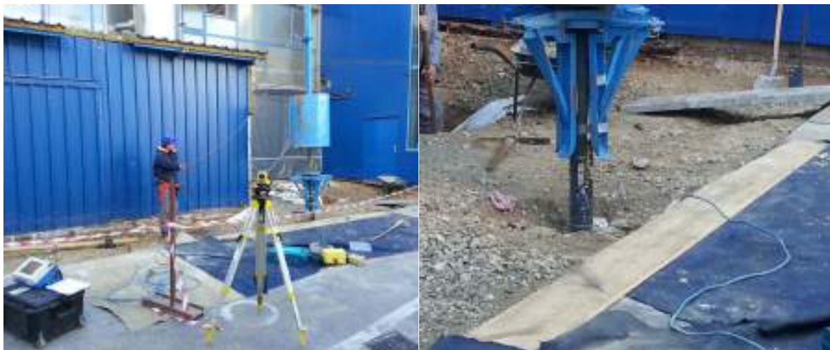
Slika 29: Izvedba meritev in instrumentacija pilota
