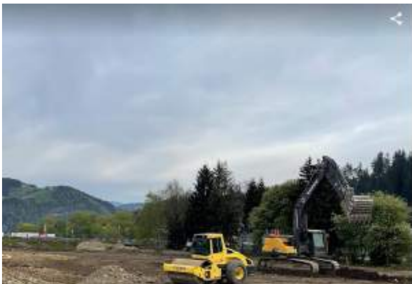
Slika 19: Izdelava spodnjega platoja na koti 416,03 m n. v. za trgovski center Slovenj Gradec
