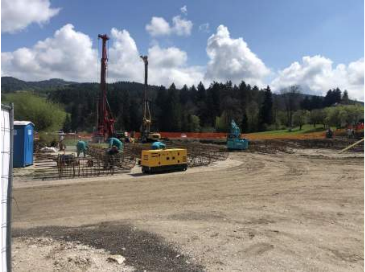
Slika 7: Vrtanje pilotov in varjenje armaturnih košev za nakupovalni center CP Ravne
