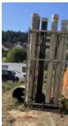
Slika 9: Kontraktorske cevi in lijak za nakupovalni center CP Ravne
