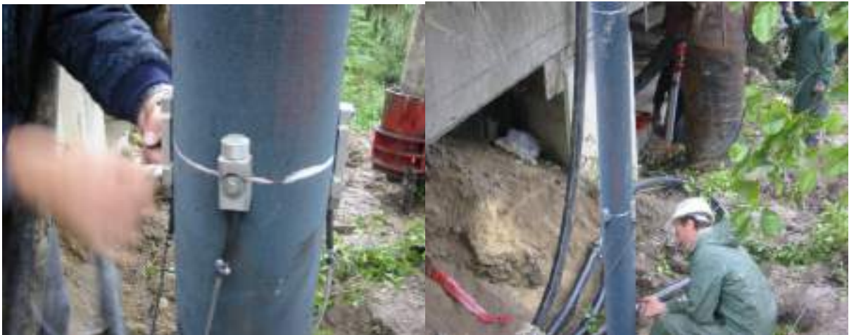
Slika 27: Test nosilnosti pilotov
