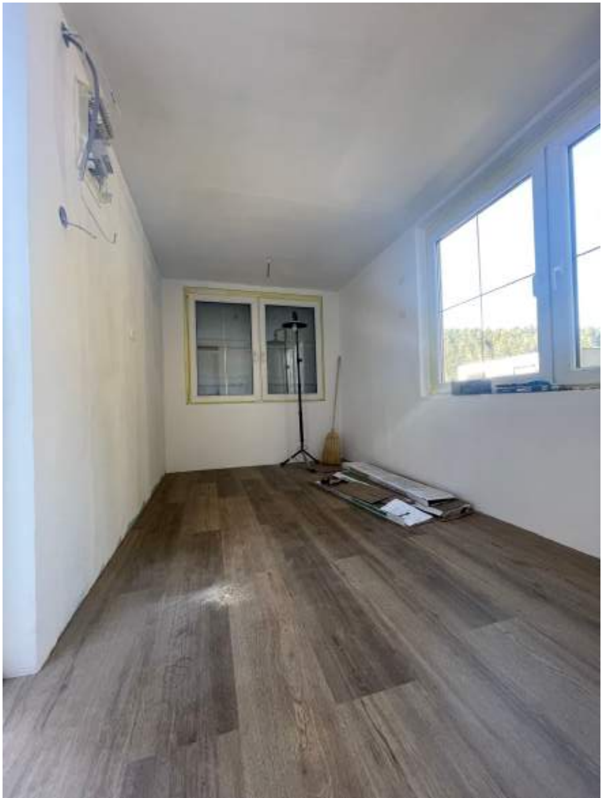
Slika 39: Beljenje in montaža vinila
