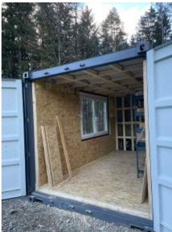
Slika 35: Montaža plošč OSB
