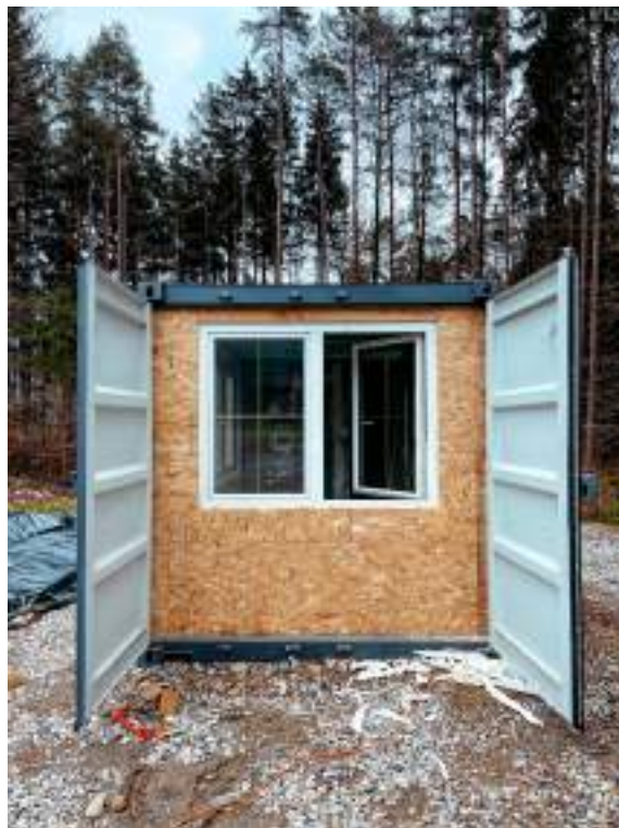
Slika 36: Plošče OSB na zunanji predelni steni
