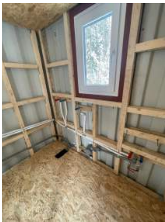
Slika 33: Prikaz napeljave vodovodnih inštalacij
