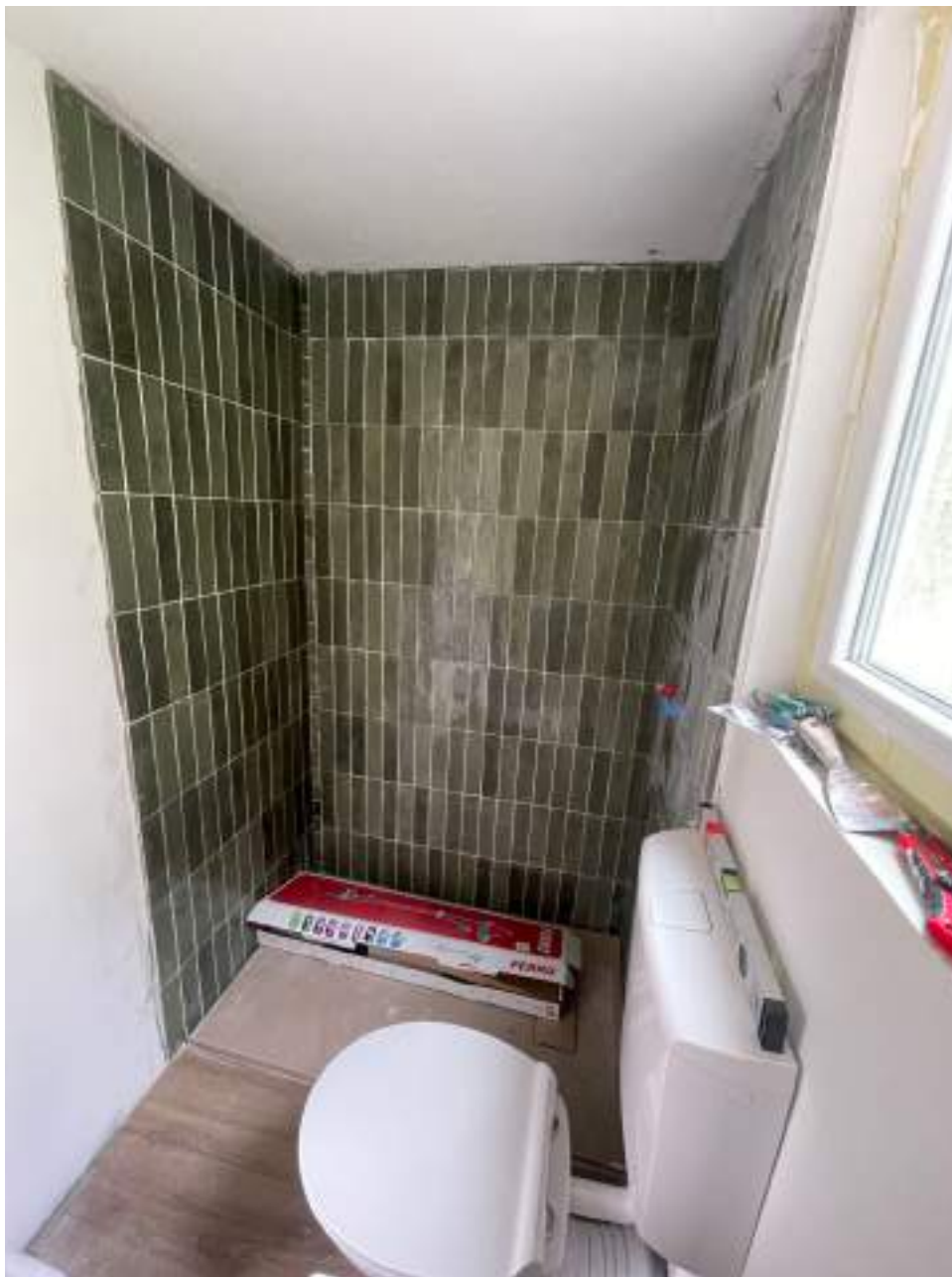
Slika 38: Montaža keramike in kopalniške opreme
