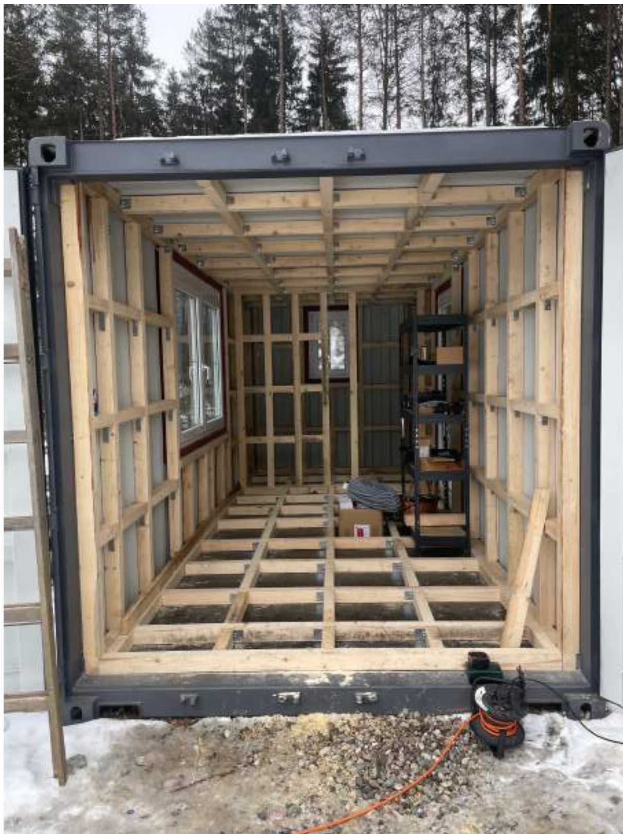
Slika 29: Postavljanje lesenih stebrov, framing (angl.)
