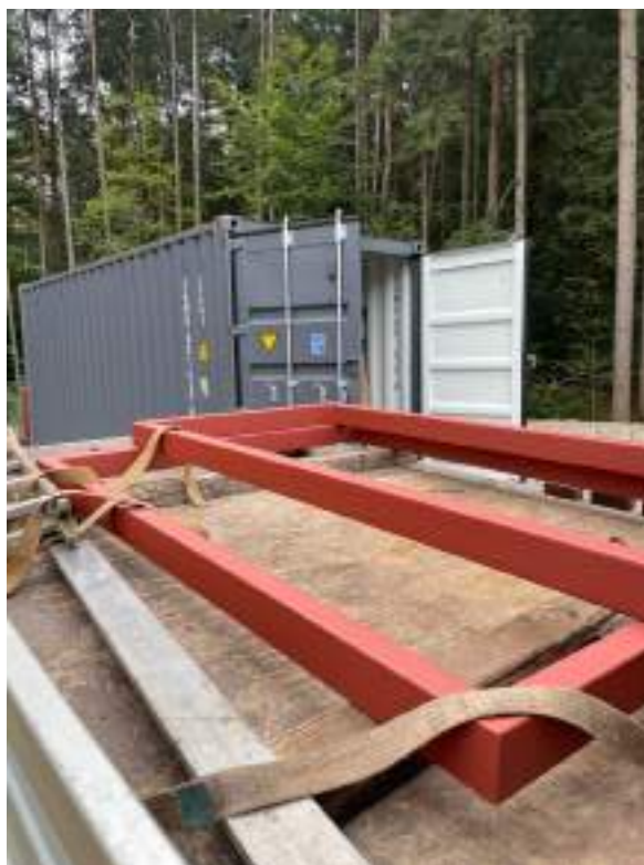
Slika 27: Železni okvirji, pripravljeni na montažo
