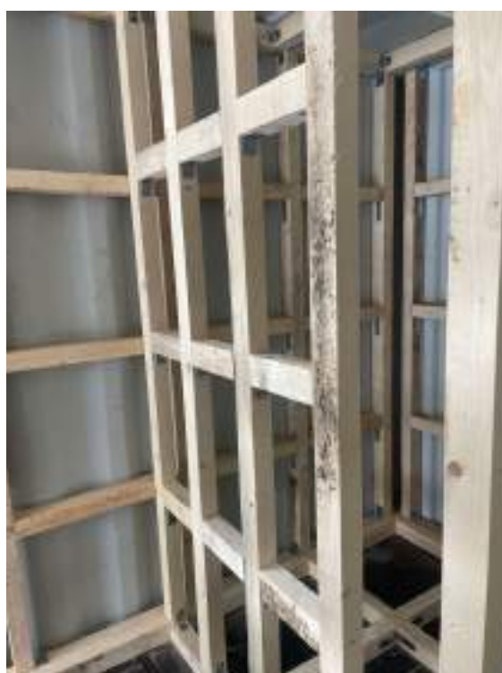
Slika 31: Predelna stena, ki loči kopalnico od osrednjega dela
