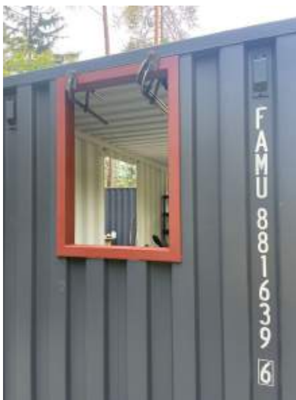
Slika 28: Montaža železnih okvirjev v odprtino
