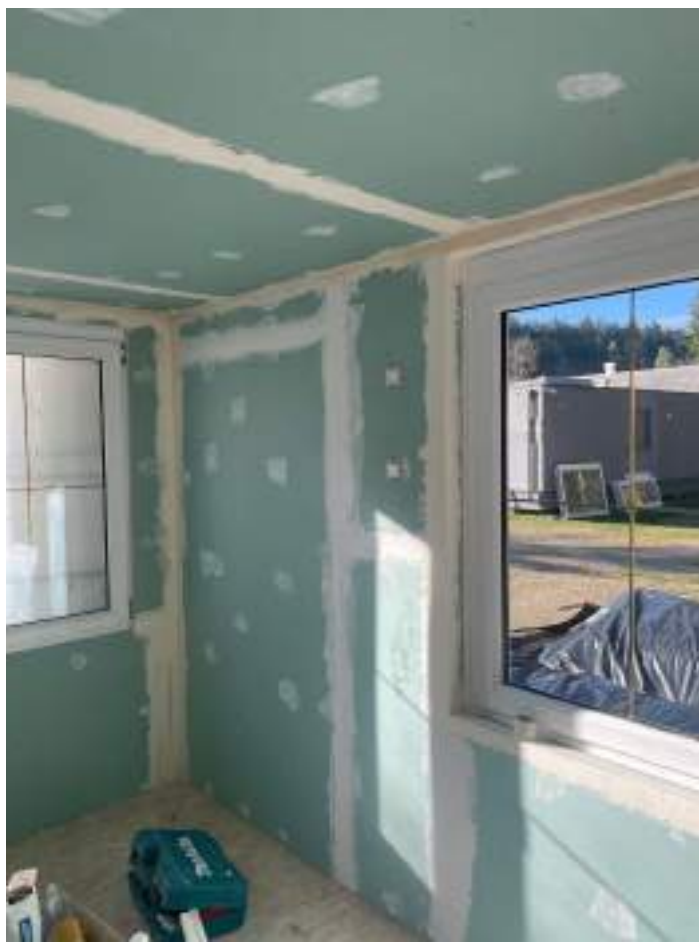
Slika 37: Nameščanje mavčnih plošč
