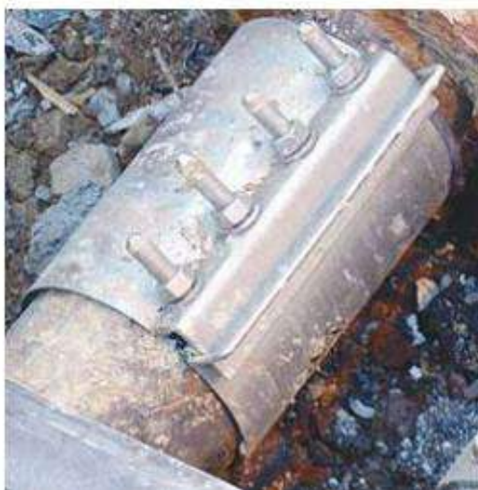
Slika 18: Primer vgrajene reparaturne spojke na lokaciji puščanja cevi
