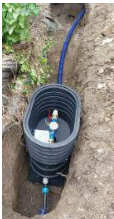
Slika 11: Primer vgrajenega vodomernega jaška za hišni priključek
