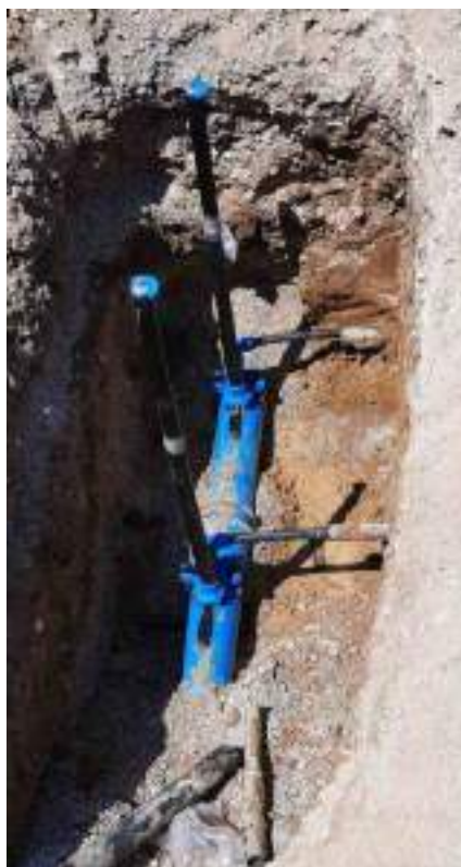
Slika 10: Primer navrtav na sekundarnem vodovodu za izvedbo hišnih priključkov
