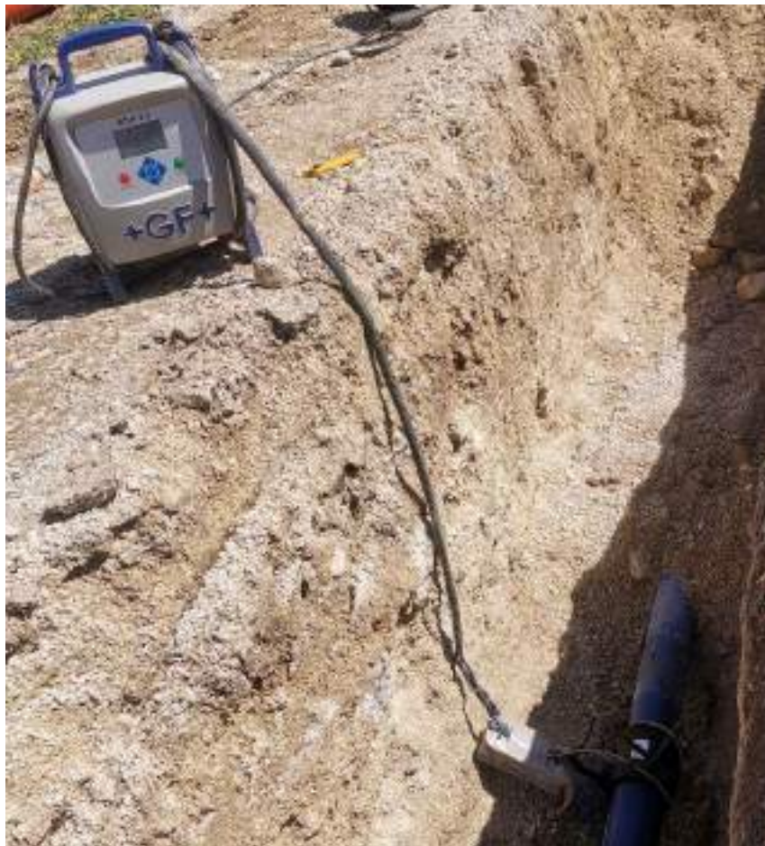
Slika 23: Primer elektrofuzijskega varjenja na gradbišču
