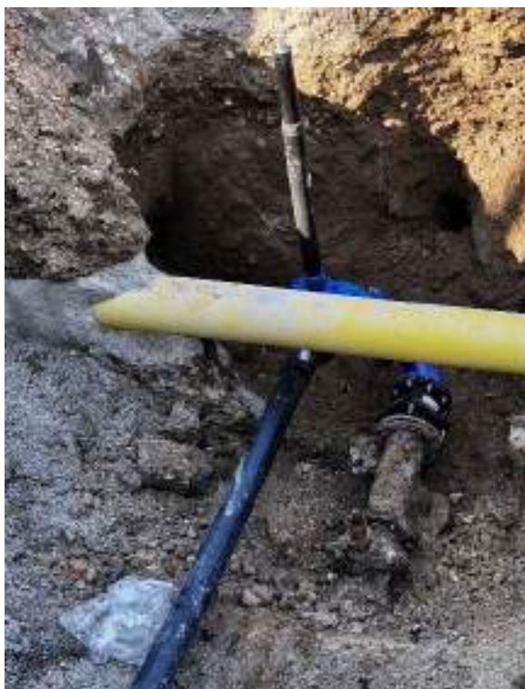
Slika 7: Navezava na obstoječi cevovod na Ljubljanski cesti
