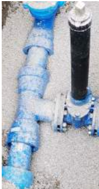
Slika 9: Primer vgrajenih fazonskih elementov
