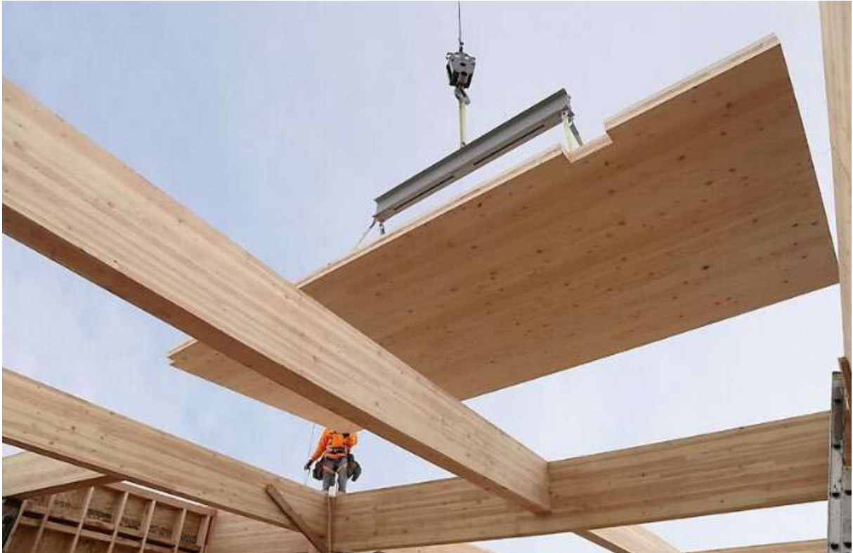
Slika 13: Skupna uporaba CLT plošče in lepljenega nosilca
