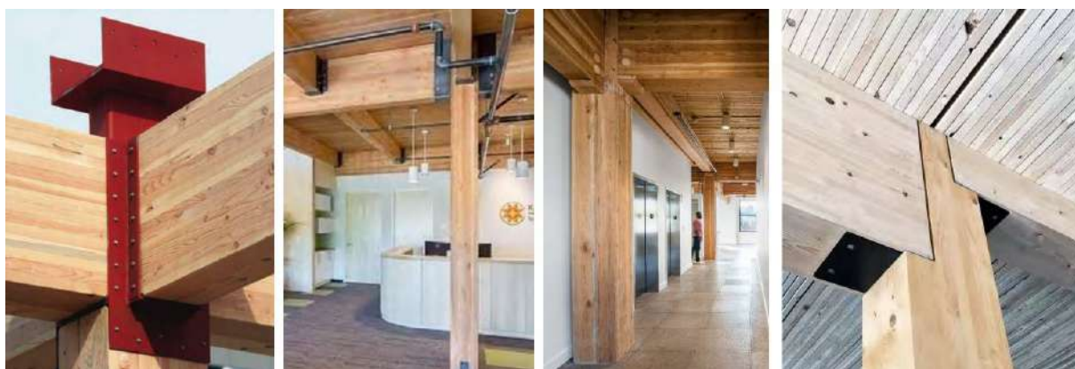
Slika 9: Različni sistemi spajanja nosilcev
