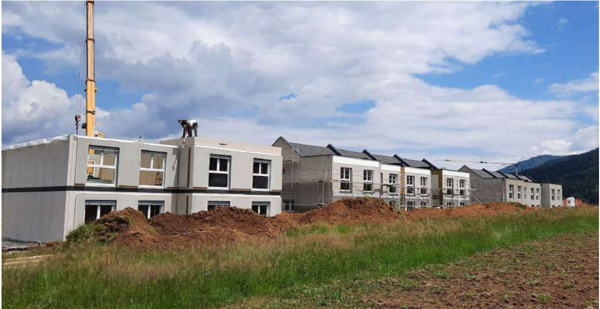
Slika 12: Celotni projekt v času gradnje
