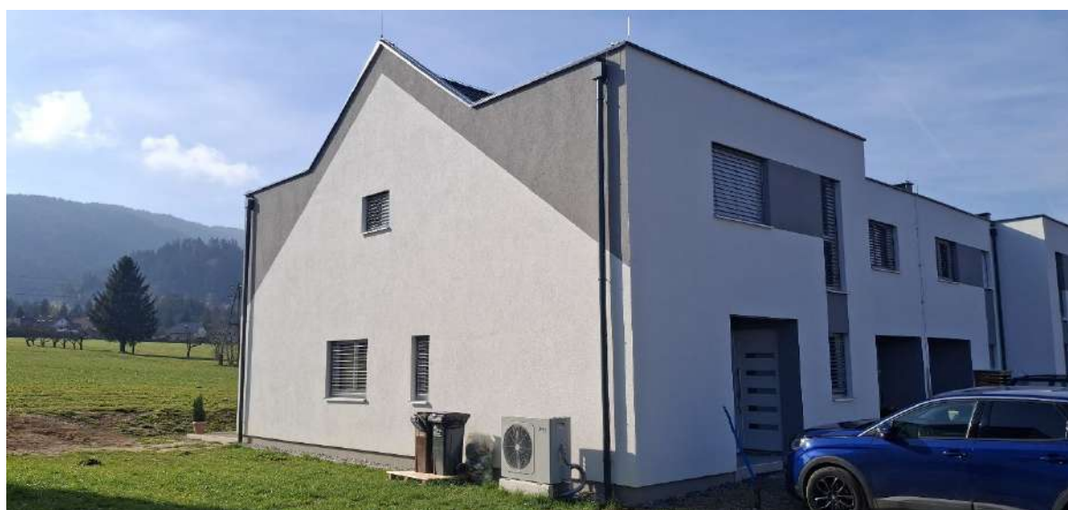
Slika 10: Stavba v zaključenem stanju s strani
