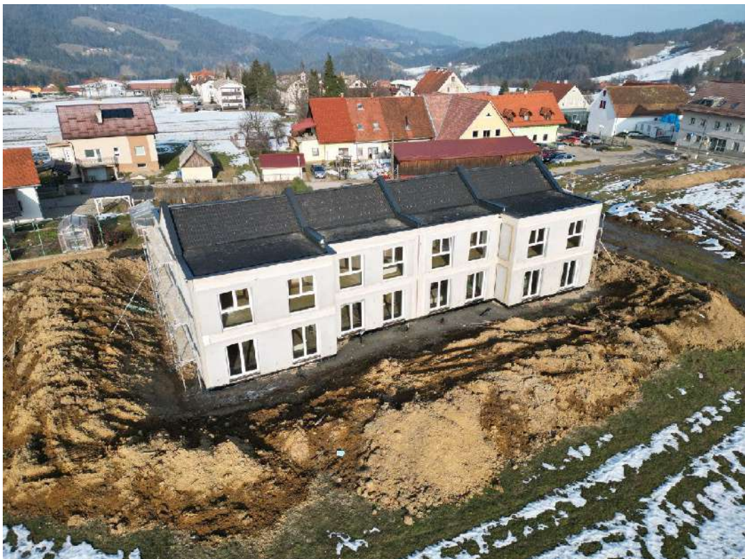
Slika 11: Stavba v času gradnje
