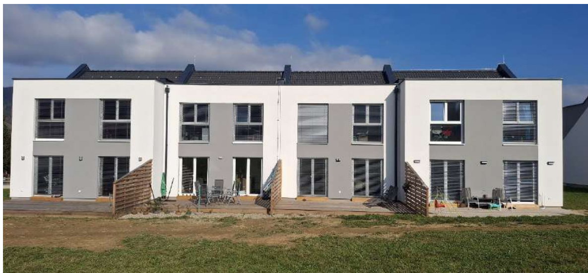
Slika 9: Stavba v zaključenem stanju z zadnje strani JZ
