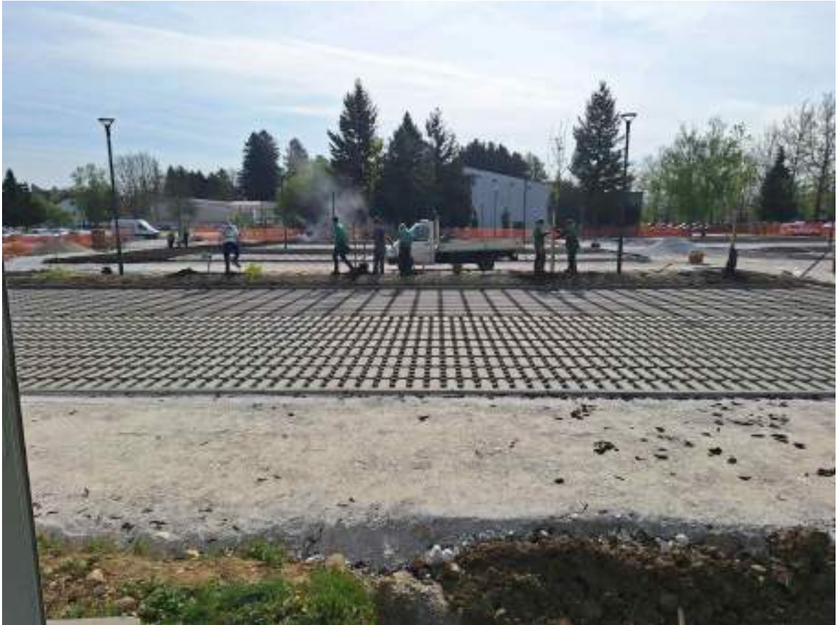
Slika 8: Parkirišče v fazi izvedbe
