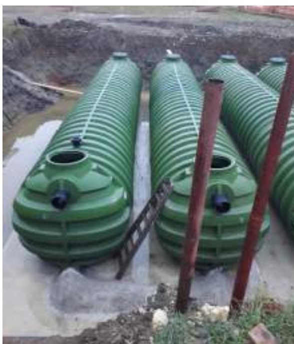
Slika 2: Rezervoarji projekta Zeleno parkirišče
