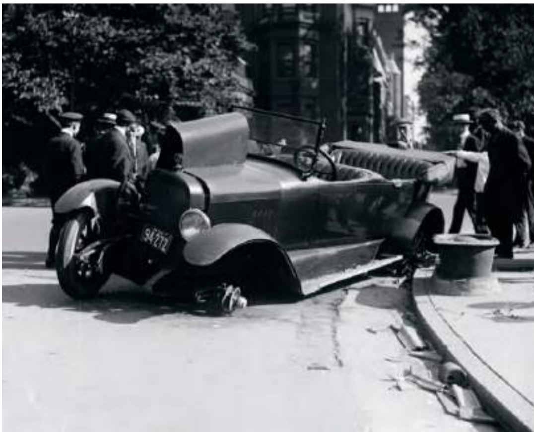
Slika 4: Poškodba koles po nepravilnem parkiranju.
