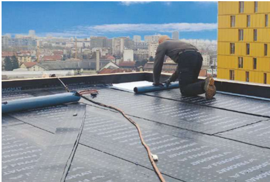
Slika 1: Izvedba bitumenske hidroizolacije
