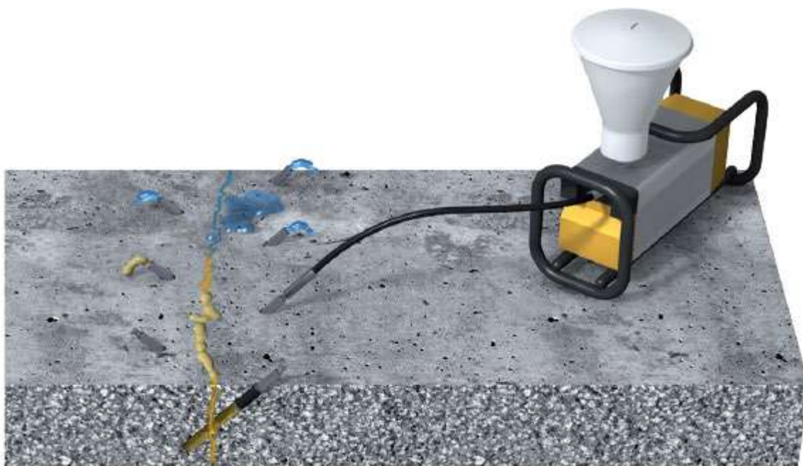
Slika 15: Prikaz injektiranja
