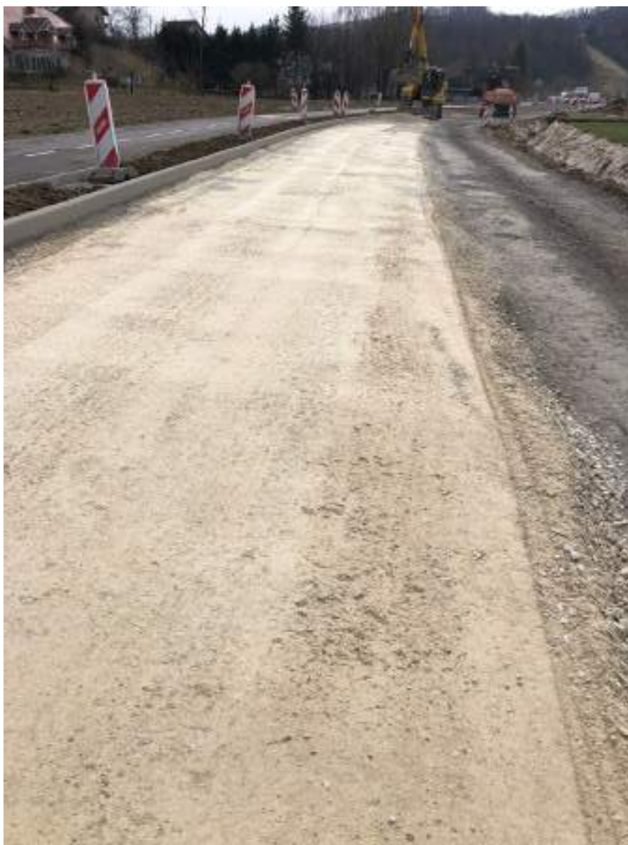
Slika 1: Izvedba zgornjega ustroja ceste.
