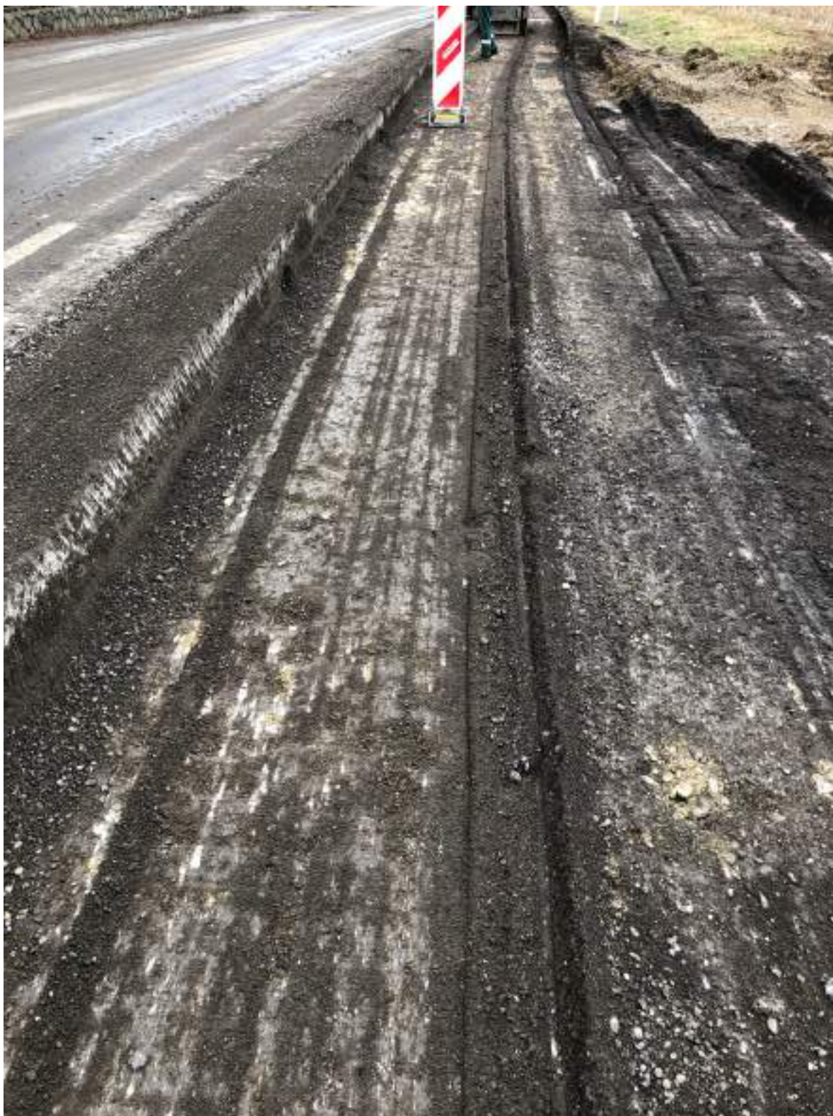
Slika 13: Izvedba odstranitve asfalta z rezkanjem.
