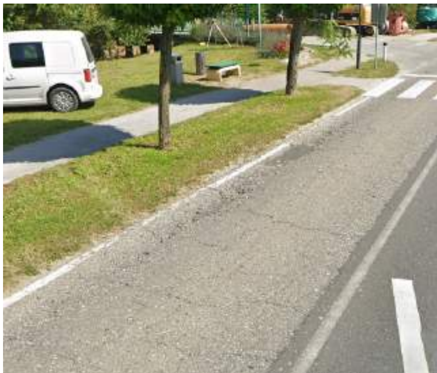
Slika 12: Stanje vozišča pred začetkom gradbenih del.
