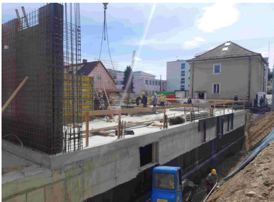
Slika 2 Zgrajena varnostna ograja med izvedbo AB del in ustrezno nošenje OVO na gradbišču ZP Magdalena
