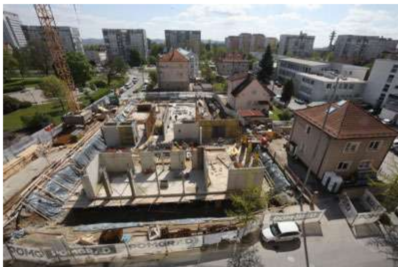
Slika 1 Ustrezno ograjeno gradbišče ZP Magdalena
