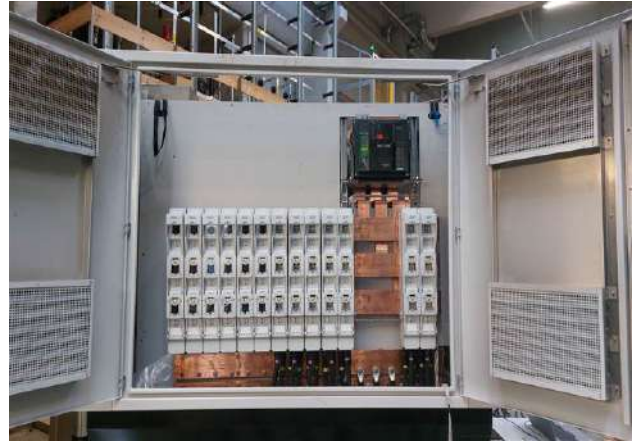
Slika 4: Transformatorska postaja znotraj.
