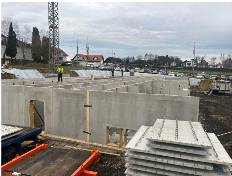
Slika 17: Primer montaže »sandwich« elementov
