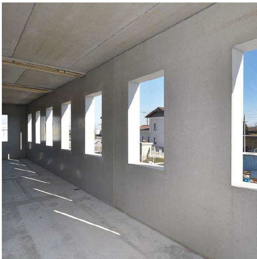
Slika 10: Fotografija vgrajenih stropnih in stenskih elementov
