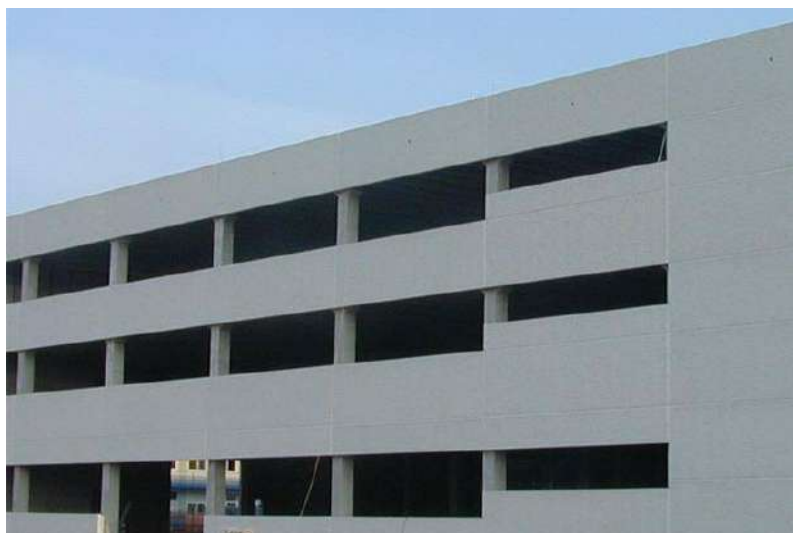
Slika 14: Fotografija prikaza vidnih betonov
