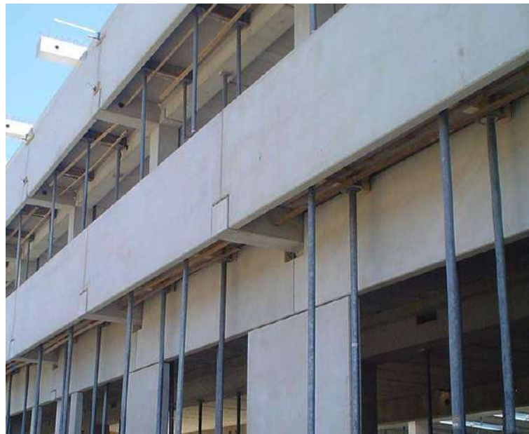
Slika 12: Fotografija primera izvedbe ograje na večstanovanjskem objektu
