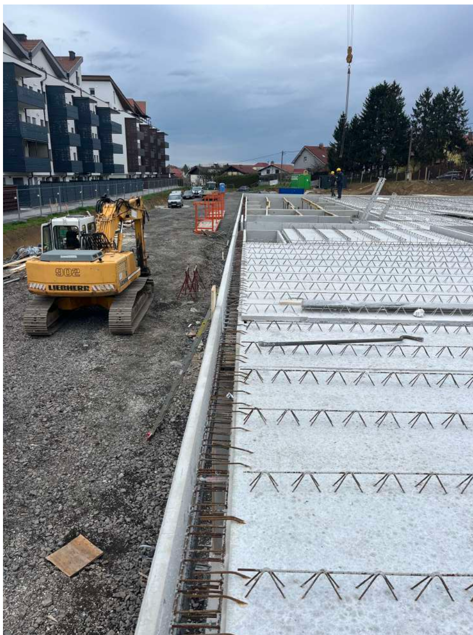
Slika 19: Primer naleganja stropnih elementov na stenske »sandwich« elemente
