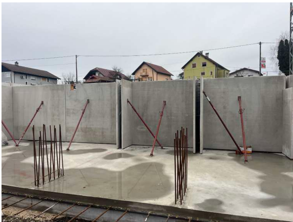
Slika 18: Stabiliziranje »sandwich« elementov s podporniki
