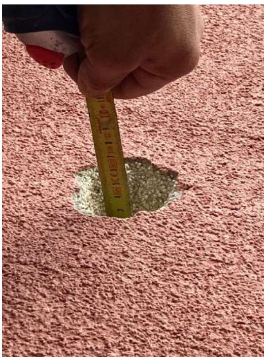
Slika 11 Obstoječa izolacija na obravnavanem objektu
