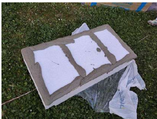
Slika 14 Nanos lepila na obravnavanem objektu
