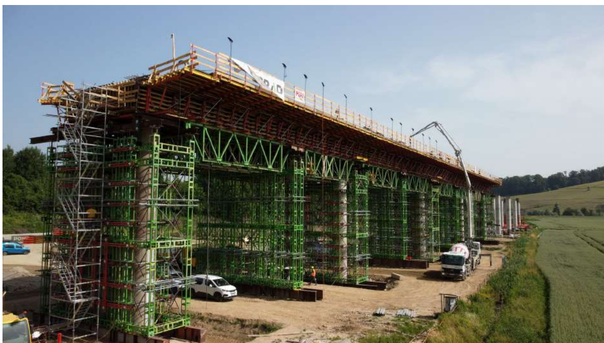
Slika 5: Betoniranje prekladne konstrukcije viadukta Pesnica
