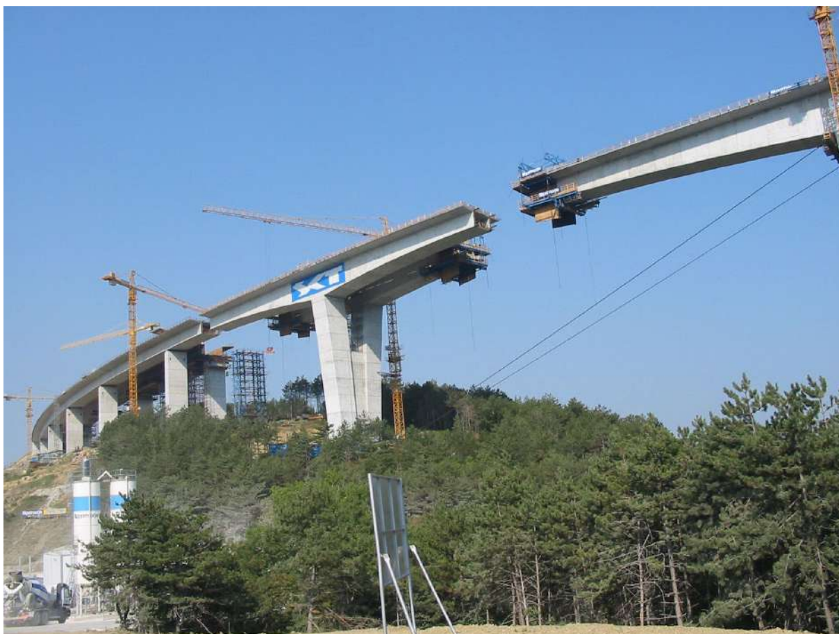
Slika 4: Gradnja viadukta Črni Kal
