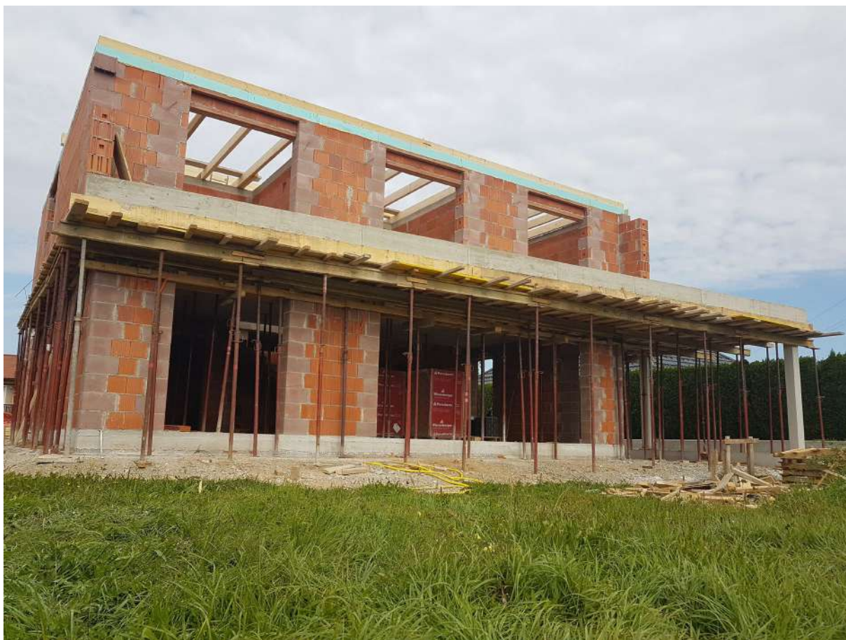
Slika 3: Gradnja stanovanjskega objekta
