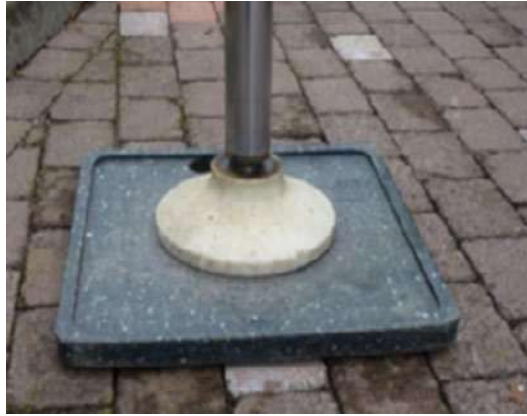
Slika 12: Pravilna porazdelitev obremenitve
