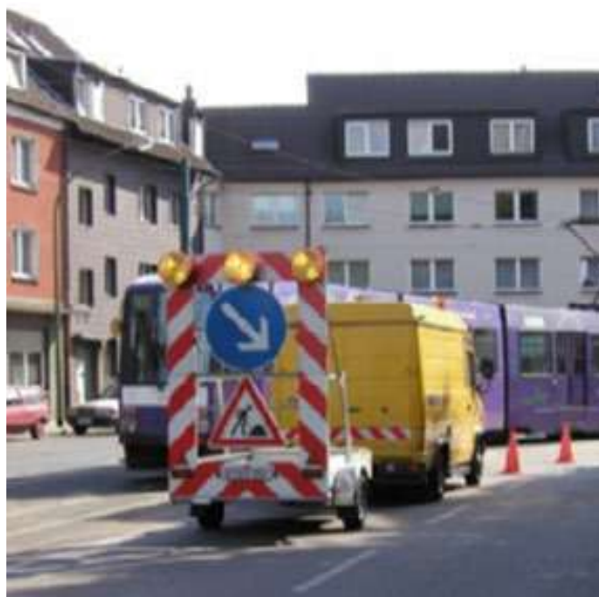
Slika 14: Primer zaščite delovišča na javni cesti
