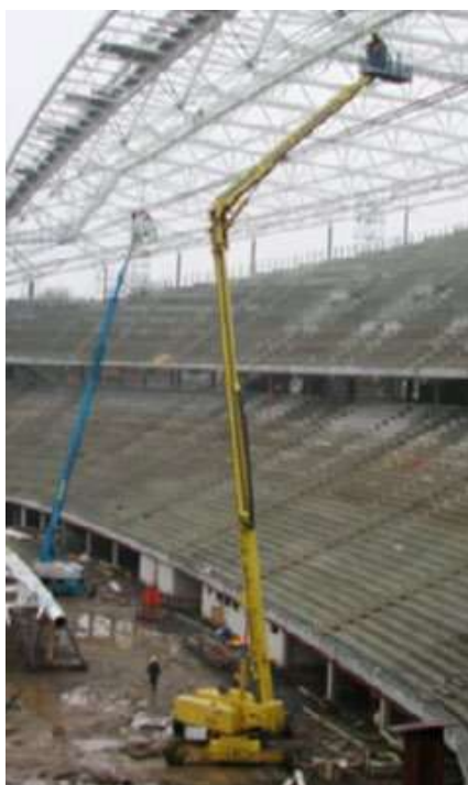
Slika 17: Uporaba dvižne ploščadi na gradbišču
